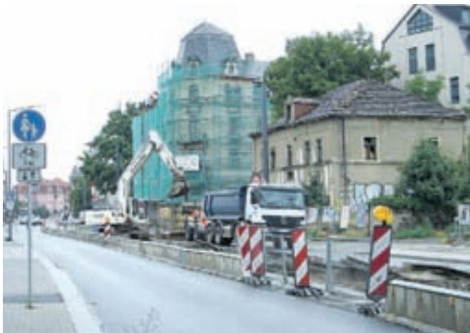
Die Bauarbeiten haben begonnen.
